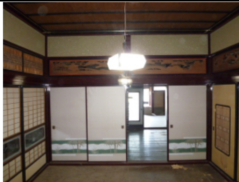
写真番号 8 調査場所 ③和室8畳 状況メモ 西面
